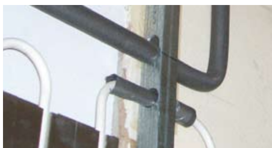
Durchführungen durch Ständer mit weichfedern-dem Dämmstoff polstern.
