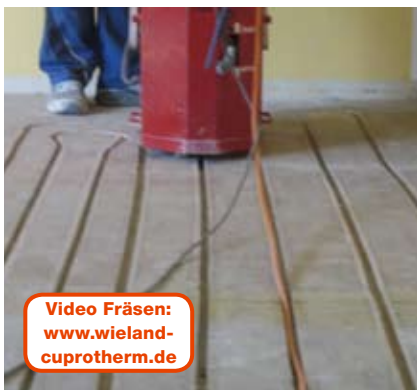
Fräsmaschine im Einsatz – sauberes Arbeiten. Das Fräsgut wird sofort abgesaugt
