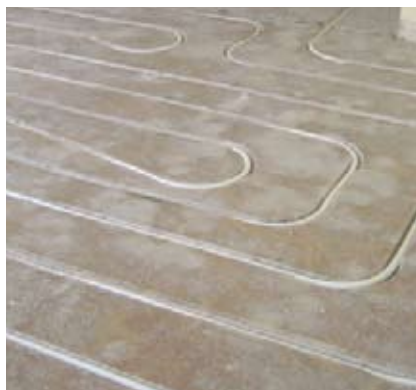
Eingelegte cuprotherm CTX-Rohre (mit Ummantelung)
