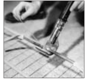
12. Verbinden der Rohre durch Hartlöten mit flussmittelfreien Hartloten.
