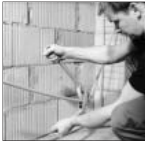
18. Biegen der Anbindestücke für die Anbindung an den Heizkreisverteiler. Lötstelle im Boden ist vorzuziehen. Decken über unbeheizten Räumen/Erdrich: ausreichend Abstand zur Dämmung der Anbindeleitungen vorsehen.
