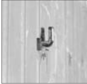
14. Empfehlung für die Einmann-Montage: Gewindehaken zum Aufhängen des Heizregisters.
