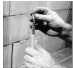
20. Stützhülse einschieben.
