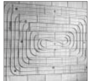
24. Spülen und Entlüften der Anlage, anschließend endgültiges Befüllen und Druckprobe mit 10 bar - 1 Std. Nach Druckprobe Lotstellen durch Zurückklappen des Mantels schließen, Längs- und Querschlitze mit Klebeband umwickeln. Rohre während des Verputzens nicht aufheizen. Vor dem ersten Aufheizen Standzeit des Putzes einhalten. Während der Maler- oder Tapezierarbeiten Rohre nicht aufheizen.
