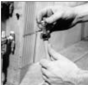
21. Überwurfmutter überschieben und Klemmring aufsetzen.
