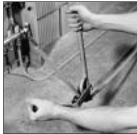
19. Verlegen der Anbindeleitung: Biegemaß anzeichnen, Anbiegen des Rohres um 90° senkrecht nach oben mit Biegegerät. Verlegen der Anbindeleitung vom Verteiler zur Anbindestelle beim Vor- und Rücklauf. Abmanteln am Rohrende auf ca. 50 mm Länge. Rohrende außen und innen kalibrieren.
