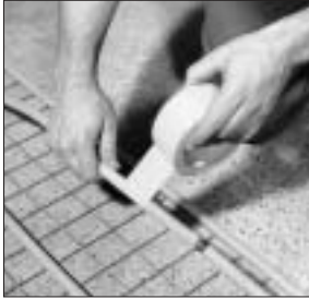
13. Die Druckprobe erfolgt vor dem Verputz. Ist kein Verteiler vorhanden bzw. keine Anbindung möglich, erfolgt die Druckprobe an jedem einzelnen Heizregister, anschließend Zurückklappen des Mantels, Längs- und Querschlitze mit Klebeband umwickeln.
