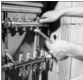
22. Einschieben des Rohrendes in das Ventil, Festschrauben des Rohres am Heizkreisverteiler mit zwei Schlüsseln.
