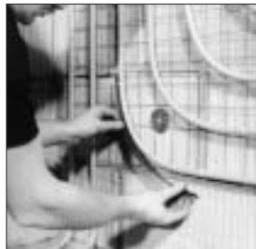
23. Auspolstern der Bögen am Außenradius bei geraden Längen über 5 m mit Schaumpolsterband.
