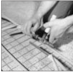
10. Rohrenden innen und außen kalibrieren und mit dem Reinigungsfließ säubern.
