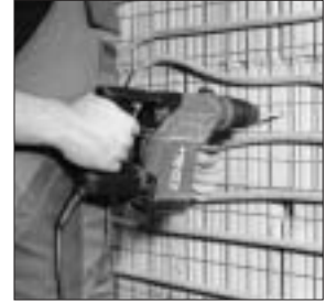
16. Setzen der Bohrlöcher für die Tellerdübel.
