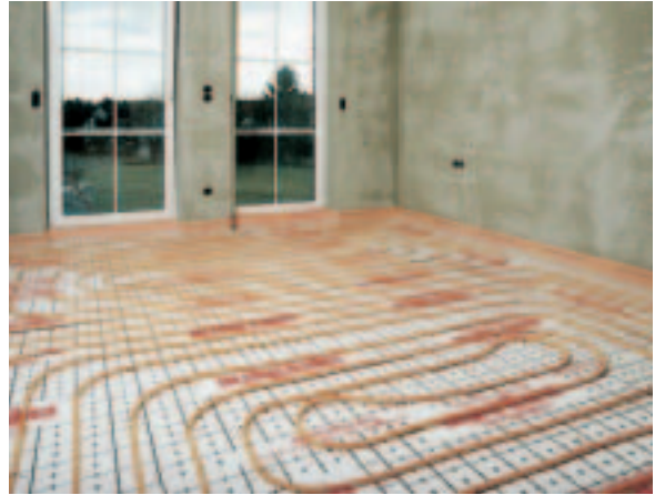
4. Verlegte Fläche mit cuprotherm.plus-Rohren.
