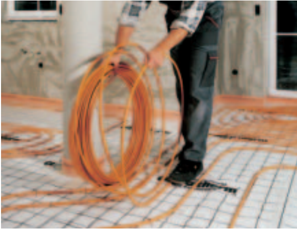
1. Verlegung der cuprotherm.plus-Rohre.
